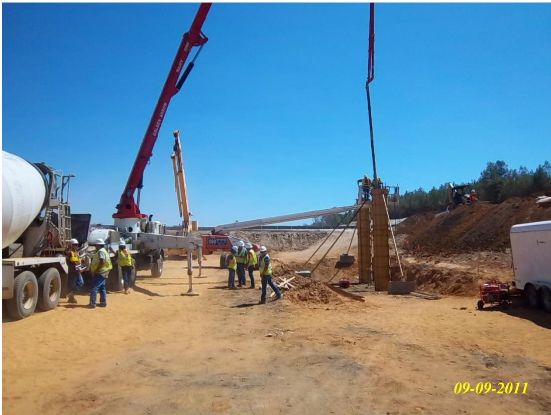
Toll 49 Segment 3B – Column concrete pour at CR 1145 Bridge
