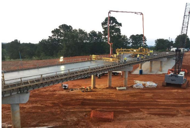
Concrete pour of CR 4118 bridge deck
