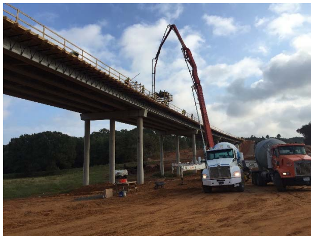
Concrete deck pour for the CR 431 overpass
