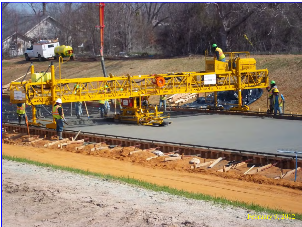
SH 64 Concrete Ramp Pour with Screed
